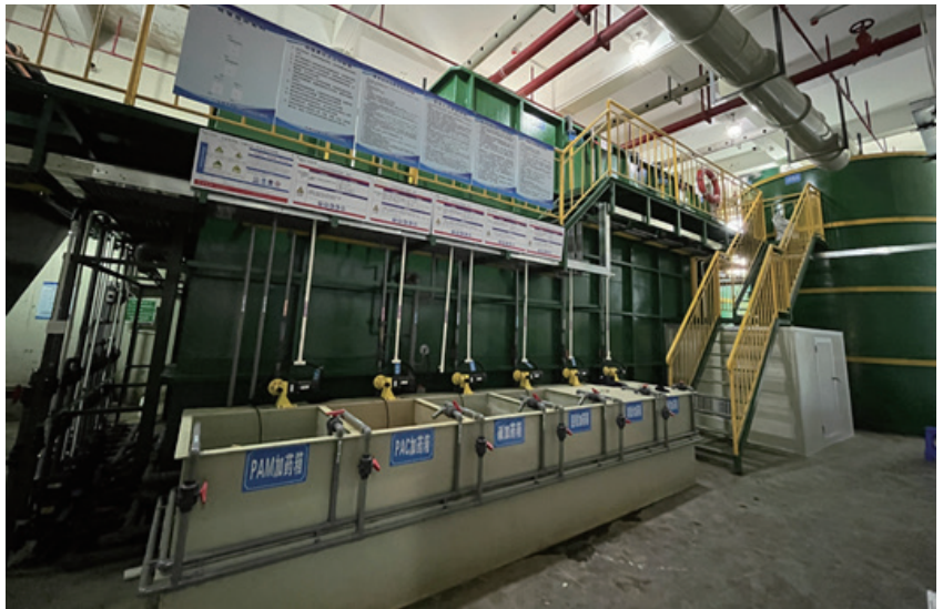
● 污水处理设备扩建
